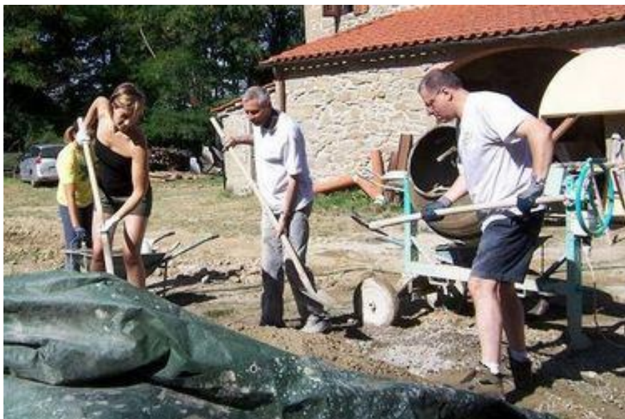
Un campo di lavoro edile (dal sito di Universitari Costruttori)
